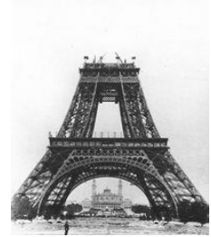
La Tour Eiffel (en construction - 1887)
